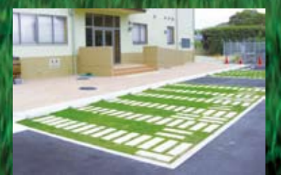
駐車場緑化グラスパーキングの採用
