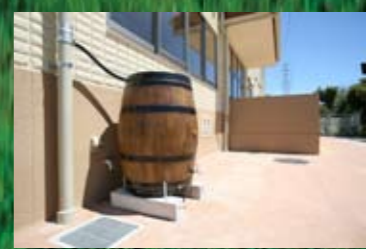
雨水貯留樽の設置
